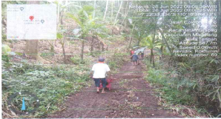
Persiapan Pembangunan JUT di Desa Kalikuto Kecamatan Grabag, 26 Juni 2022
